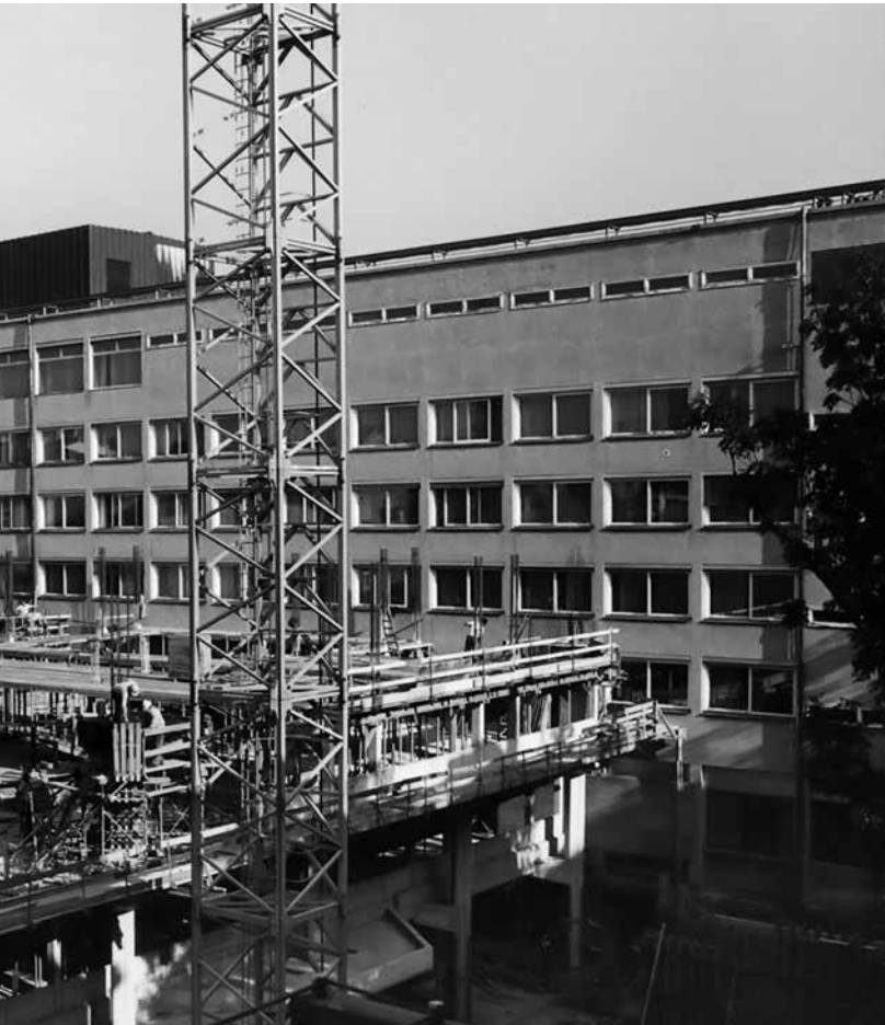
Bau des Betriebs- und Sozialgebäudes (BuS) in München-Schwabing, in dem die neue Datenverarbeitungszentrale und die Kantine der Hauptverwaltung untergebracht wurden.
