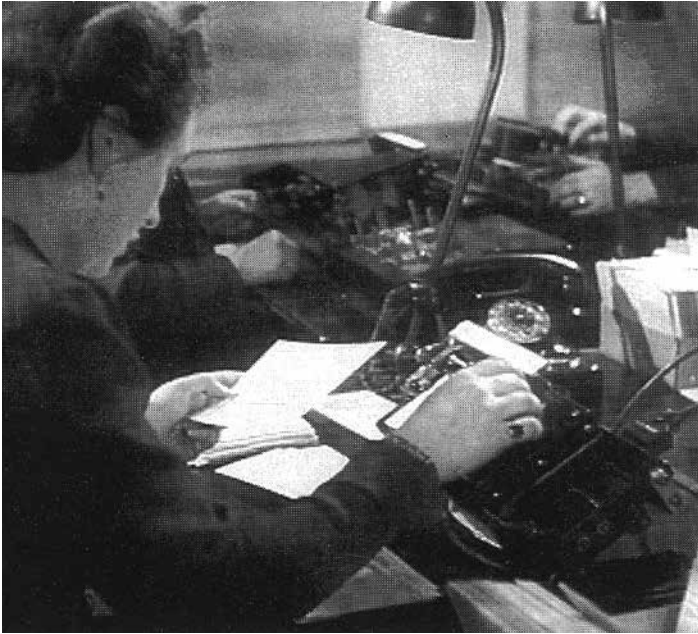
Das Handlochkartengerät diente zur Übertragung statistischer Daten auf die Lochkarte (Filmprint).
